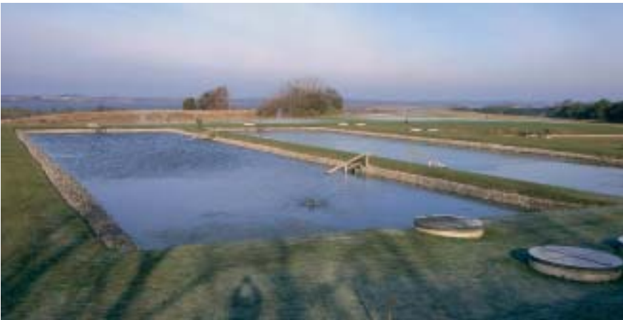
Forsøgsanlægget for kunstig infiltration på Arrenæs
